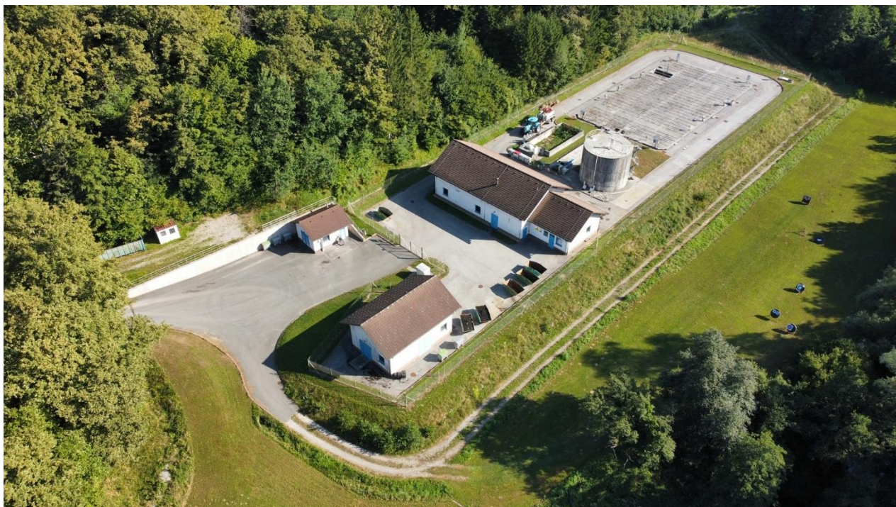
Centralna čistilna naprava (objekt za čiščenje odpadnih komunalnih voda)
