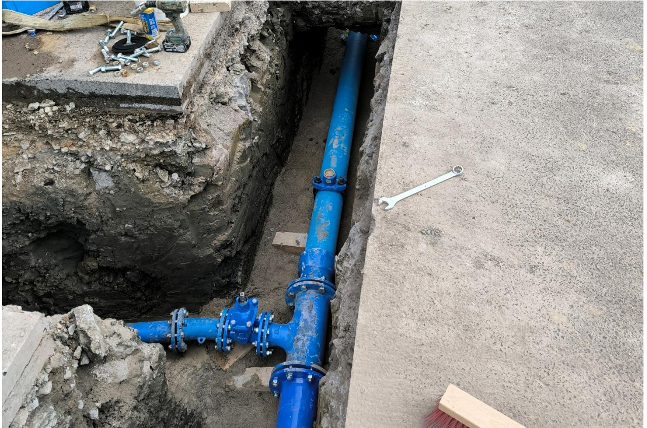
Oskrba s pitno vodo – opravljanje storitve (popravilo vodovoda,...)
